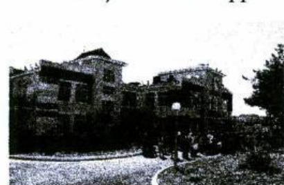
Строительство детского сада по ул. Почтовой в г. Геленджике на 120 мест
