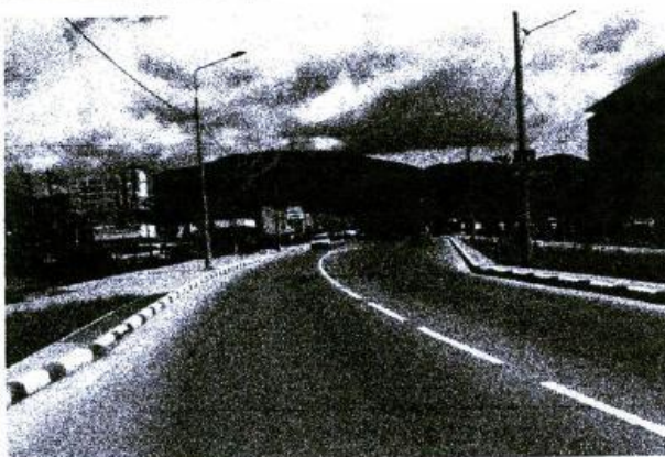
Реконструкция дорожного покрытия
