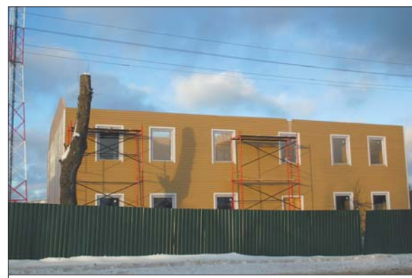
В Разбегаево строится новый дом
