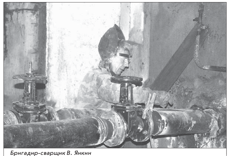
Бригадир-сварщик В. Янкин
