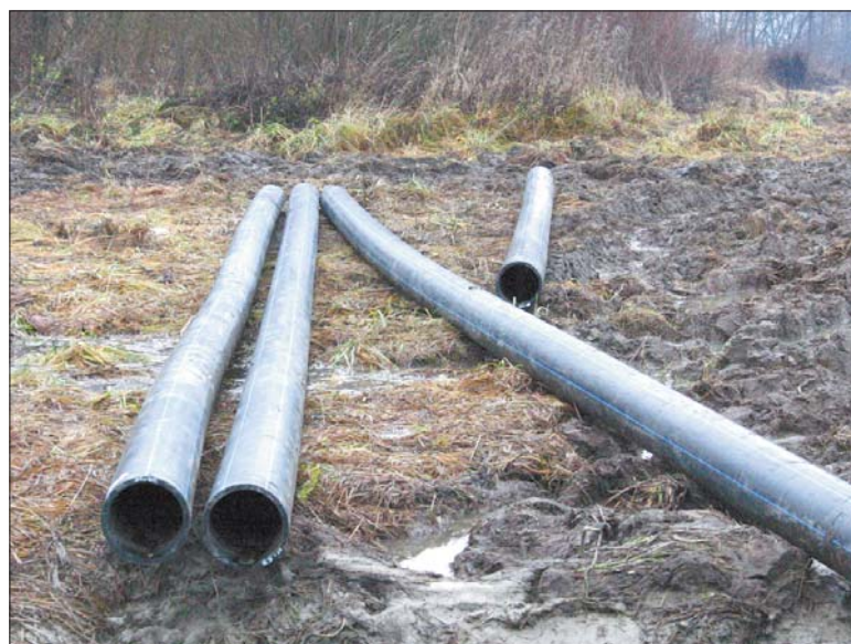
Замена водопроводных труб.
