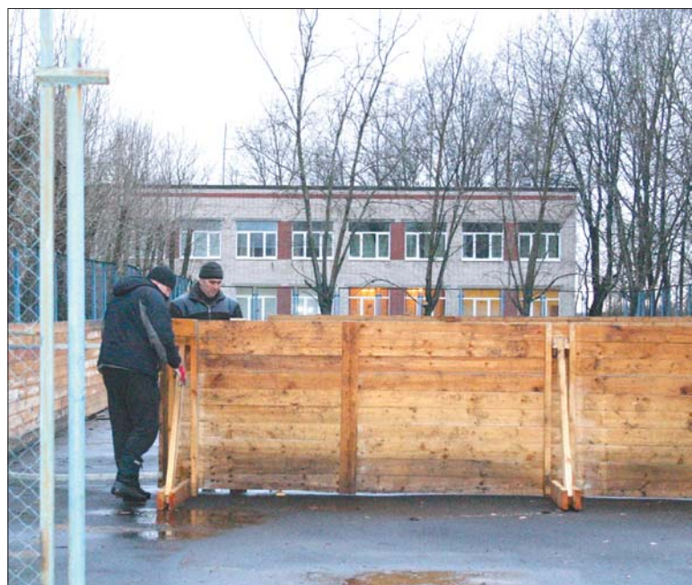
Строительство хоккейной коробки в Малом Карлино
