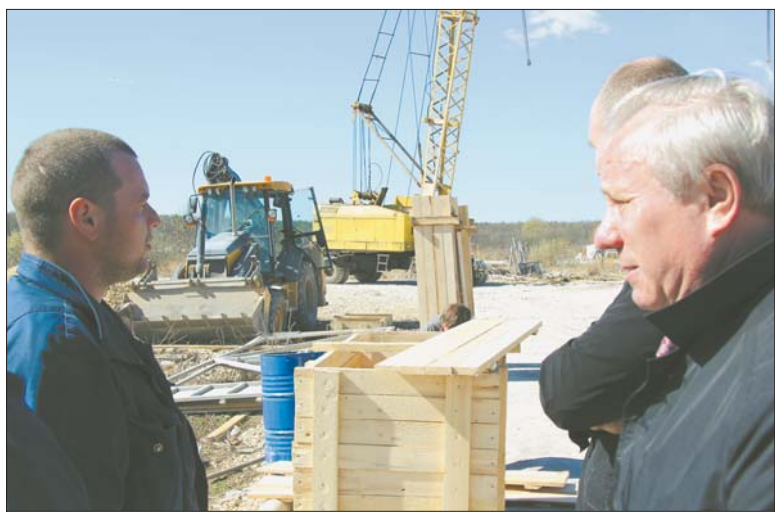
На строительстве детского сада в Новоселье
