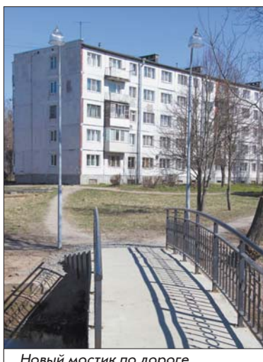
Новый мостик по дороге к будущему детсаду в Новоселье
