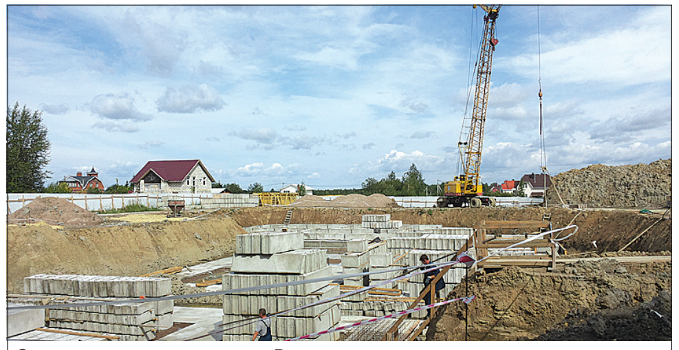
Строительство детского сада в Ропше.
