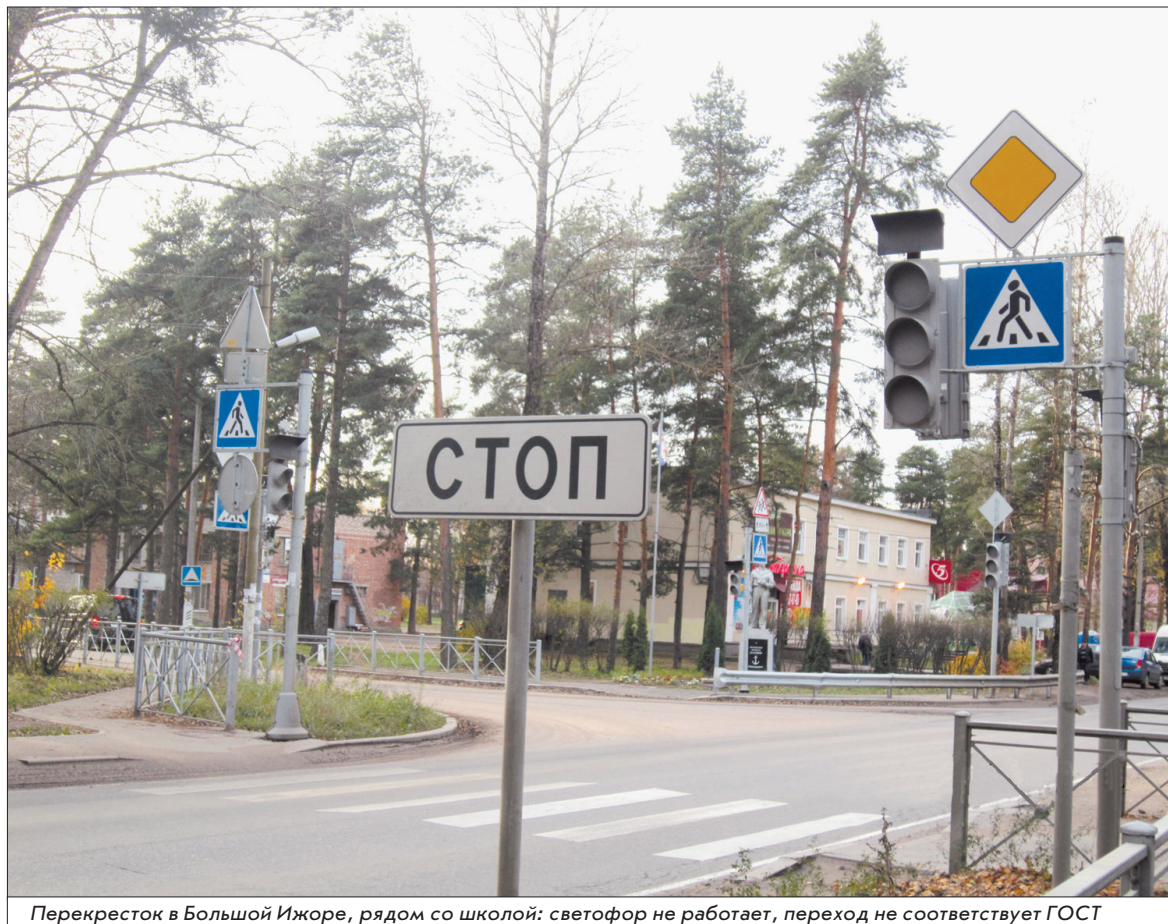
Перекресток в Большой Ижоре, рядом со школой: светофор не работает, переход не соответствует ГОСТ
