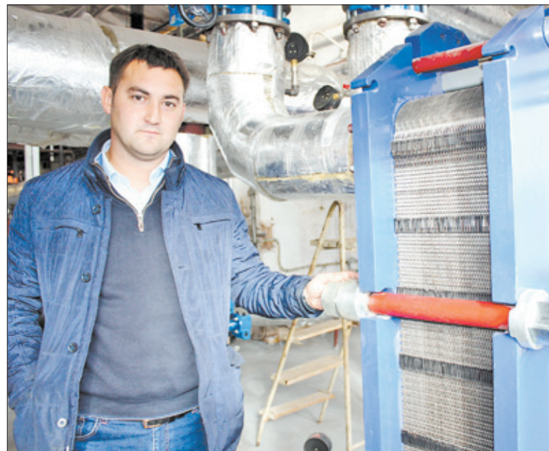
Генеральный директор ООО «ЛЕМЭК» Станислав Геер в переоборудованной котельной старой части поселка
