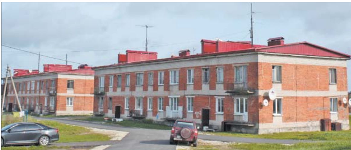
Отремонтированы кровли домов в деревне Горки
