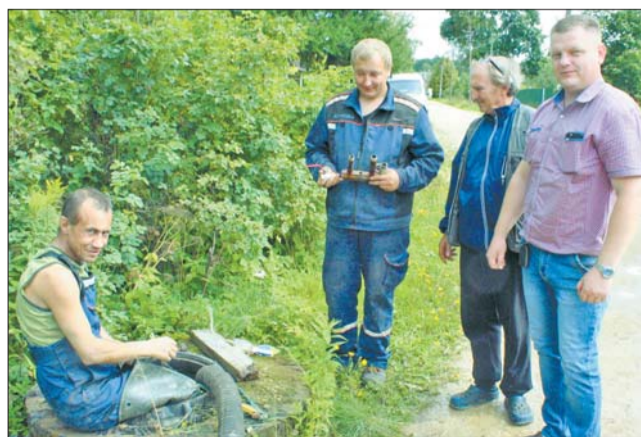
Аварийно-восстановительная бригада под руководством начальника участка Олега Юрьевича Белякова (справа) работает по заявке в пос. Лебяжье
